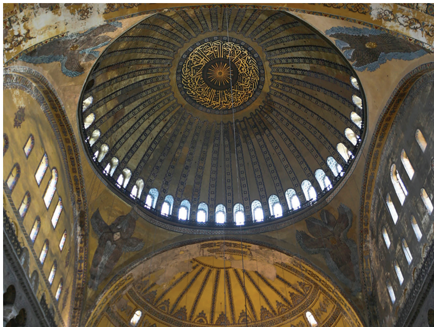
Сл. 8: Црква Св. Софије, Цариград, купола над пандантифима Fig. 8: Hagia Sophia, Constantinople, interior, dome on pendentives
