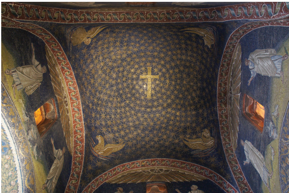
Сл. 7: Маузолеј Гале Плацидије, Равена, лоптасти свод Fig. 7: Mausoleum of Galla Placidia, Ravenna, sail vault
