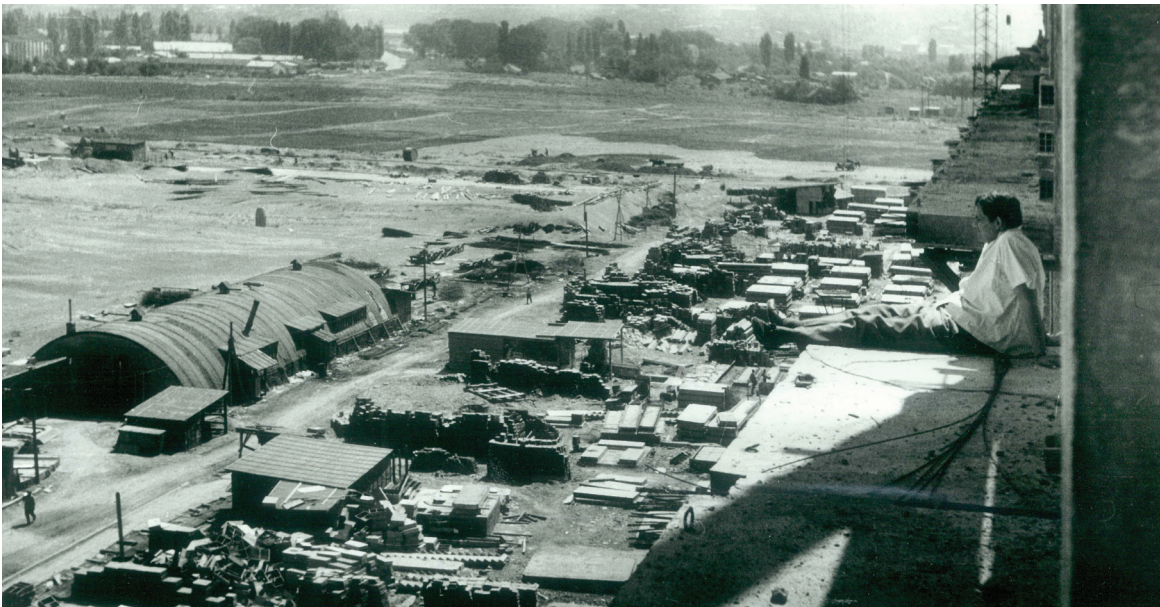
Сл. 1 Архитекта Милосав Миша Митић на градилишту стамбеног блока „В-9” у Блоку 21, 1964./ Fig. 1 Architect Milosav Miša Mitić on the construction site of Residential block B-9 in Block 21, 1964
