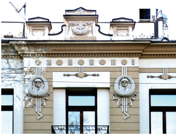
Сл. 2. Кућа Јелене Димитријевић, Француска 29, 1924. год., архитекти Игор Амосов и Радомир Тодоровић. Оригинални пројекат уличног pročеља, данашњи изглед и детаљ декорације фасаде.
