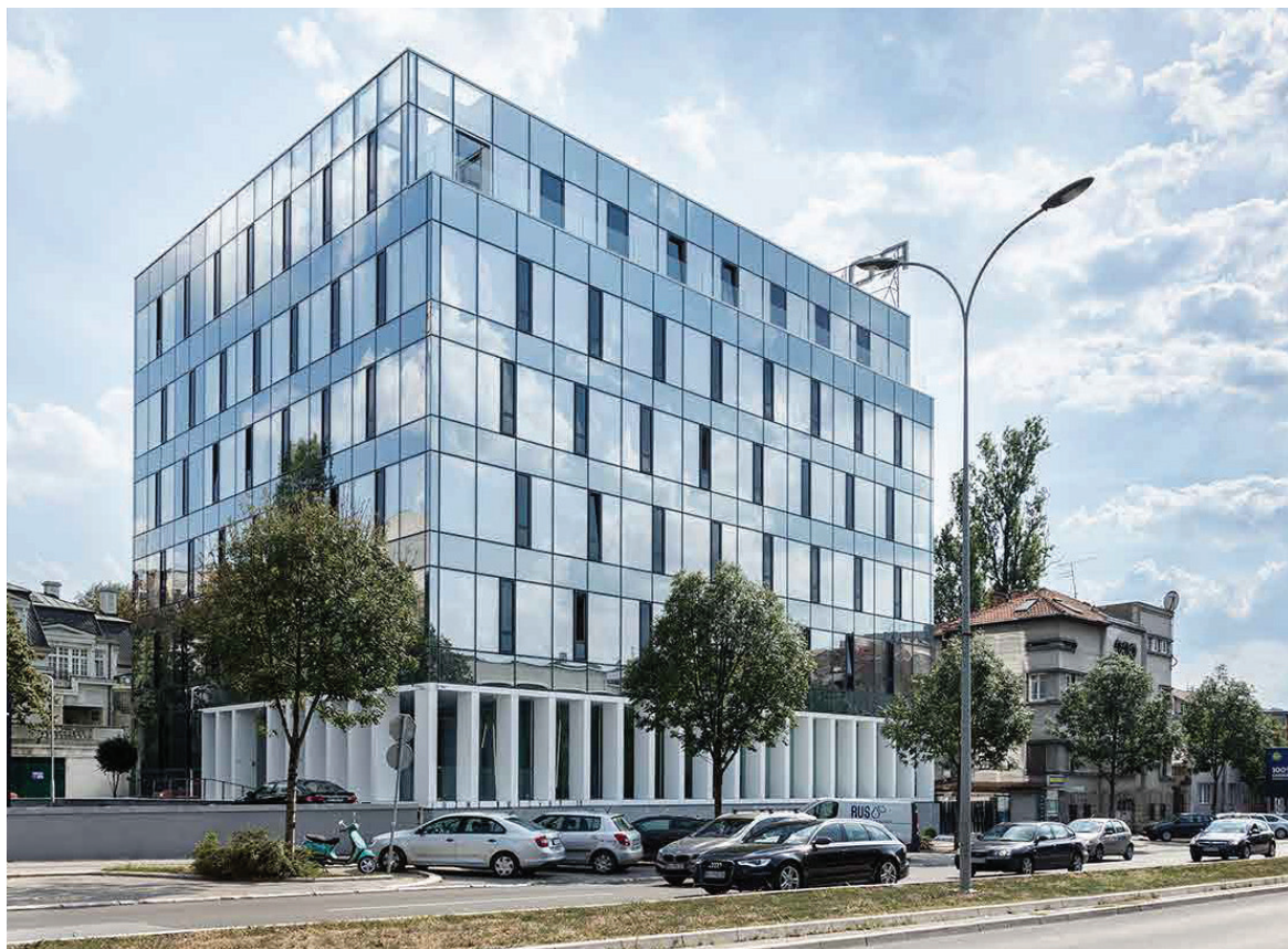
Сл. 7. Пословни објекат, поглед са улице, аутор фотографије: Реља Иванић / Fig. 7. The office building, view from the street, author of the photo: Relja Ivanić
