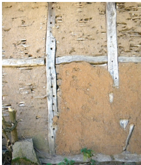
Сл. 8 Кућа Душка Костића (а), детаљ конструкције зида (б), детаљ дирека са јастуком (в) / Fig. 8 The house of Dusko Kostic (a), detail of wall construction (б), detail of a pillar with a pillow (в)
