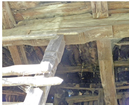
Сл. 8 Кућа Душка Костића (а), детаљ конструкције зида (б), детаљ дирека са јастуком (в) / Fig. 8 The house of Dusko Kostic (a), detail of wall construction (б), detail of a pillar with a pillow (в)
