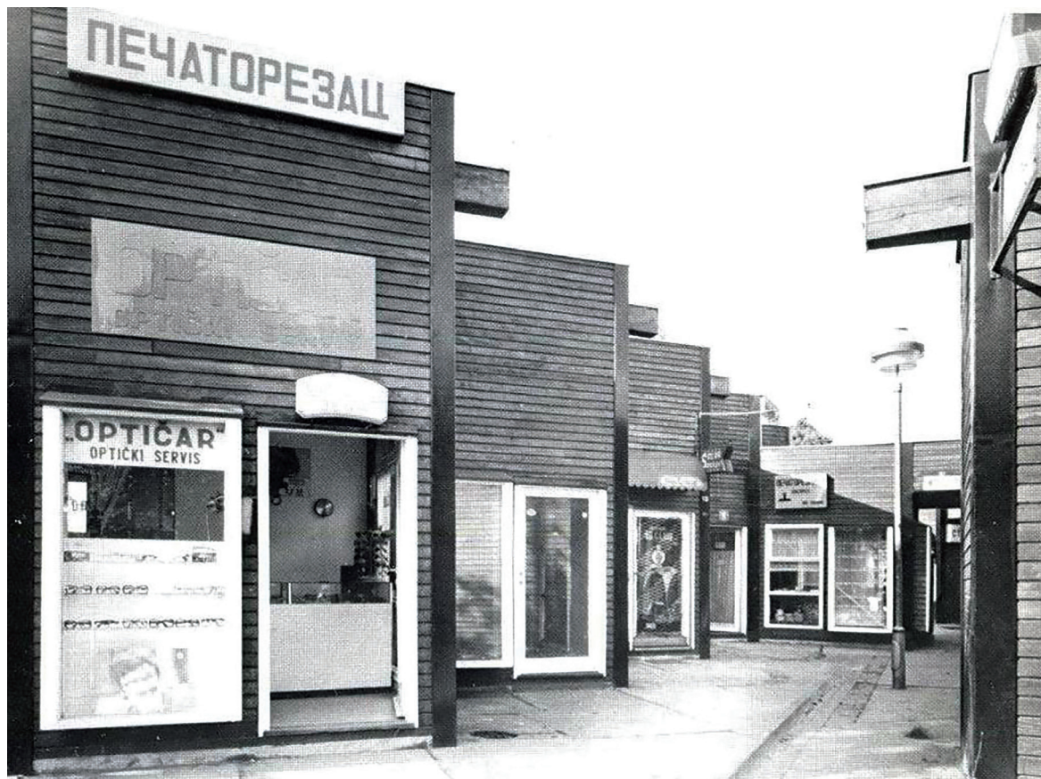
Сл. 5 Занатско-услужни центар на Врачару, типски објекти са радњама и јавни отворени простор око њих, фотографија из седамдесетих (извор: Фото документација аутора) / Fig. 5 Craft and service center in Vračar, typical buildings with shops and public open space around them, photo from the 1970s (source: Photo documentation by the authors)
