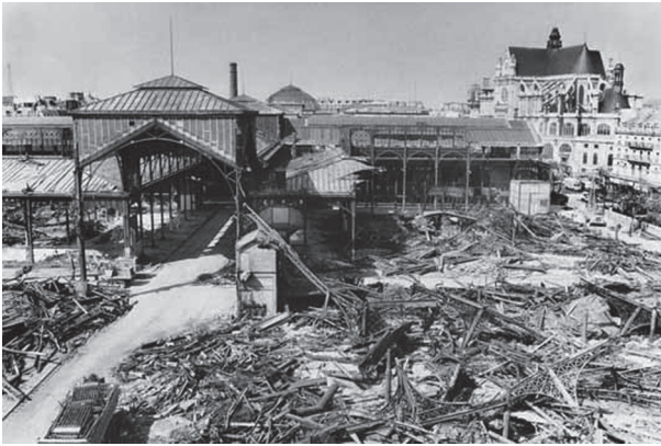
Сл. 1. Рушење комплекса Les Halles Fig. 1. Destruction of the complex Les Halles
