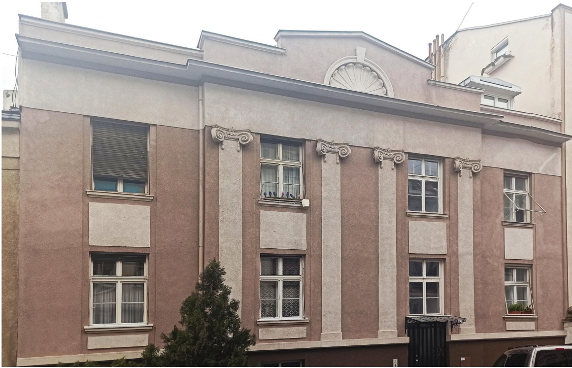
Сл. 2. Зграда Христине Јановић, данашњи изглед / Fig. 2. Building of Hristina Janović, present day appearance
