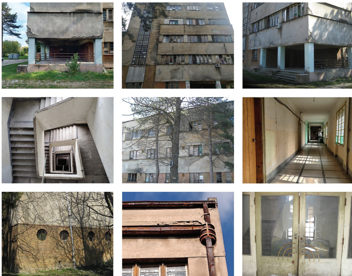
Сл. 8. Карактеристични делови простора, елементи и детаљи објекта Пилотске школе – горњи ред с лева: улазна партија, фасада угаоног волумена, издигнут део улаза у објекат; средњи ред с лева: степениште, фасада дужег волумена објекта управног на улицу, ходник дужег волумена објекта; доњи ред с лева: окулуси, детаљ олука, детаљ врата за улаз на етажу из простора степеништа, извор: аутори. / Fig. 8 Characteristic parts of the architectural space, elements and details of the building of the Pilot School, top row from the left: entrance, facade, raised part of the entrance to the building; middle row from the left: staircase, facade of the longer volume of the building perpendicular to the street, corridor of the longer volume of the building, lower row from the left: oculus, detail of the gutter, detail of the door (entrance to the typical floor from the staircase), source: authors.
