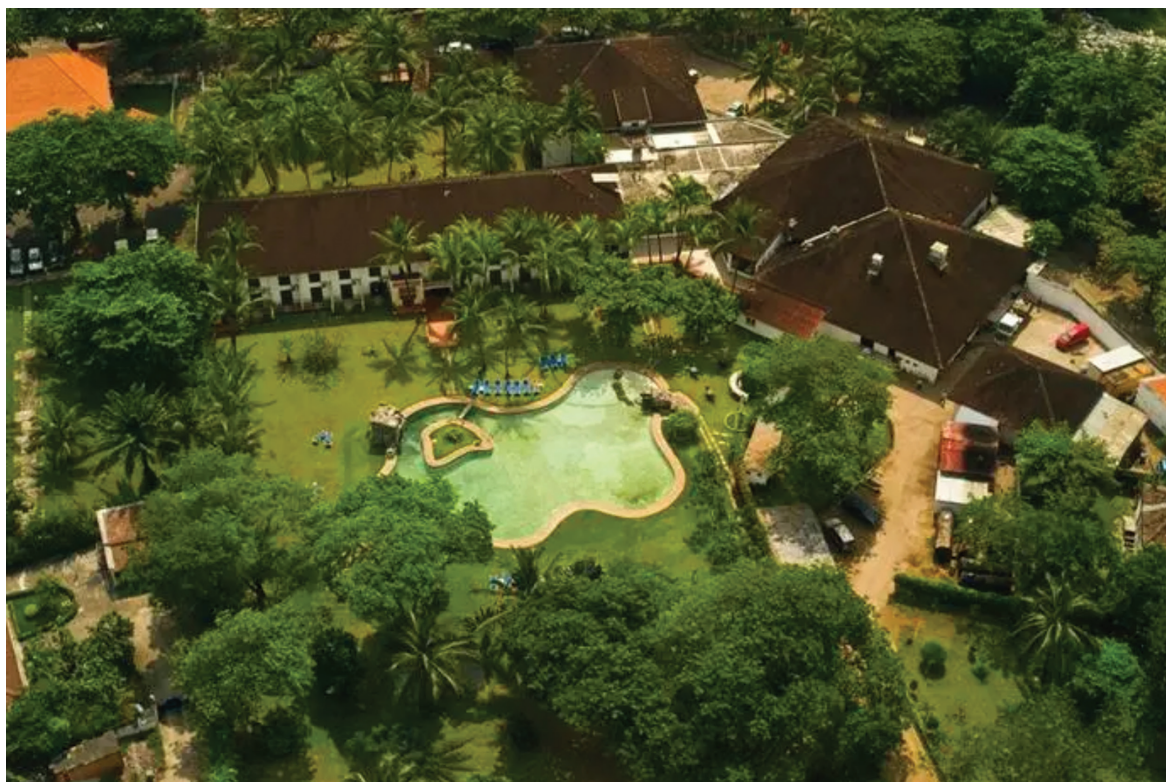
Сл. 8. Крешимир Мартинковић, главни пројектант Миодраг Радуловић ( Архитектура и урбанизам , Београд), хотел Miramar , 1985–1987, Сао Томе и Принсипе. Основа приземља и делимично ситуација (а), изглед хотела из птичје перспективе (б). Извор: Google Maps / Izgradnja , 1, 1987, 17. / Fig. 8 Krešimir Martinković, chief designer Miodrag Radulović ( Arhitektura i urbanizam , Belgrade), Miramar Hotel, 1985–1987, São Tomé and Príncipe. Ground floor plan and partial situation (a), bird's eye view of the hotel (b). Source: Google Maps / Izgradnja , 1, 1987, 17.
