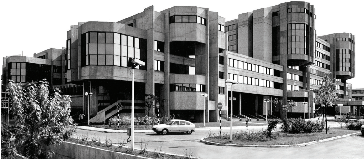
Зграда Савезног извршног већа СИБ III, Нови Београд, арх. Љупко Ђурчић, 1975.
