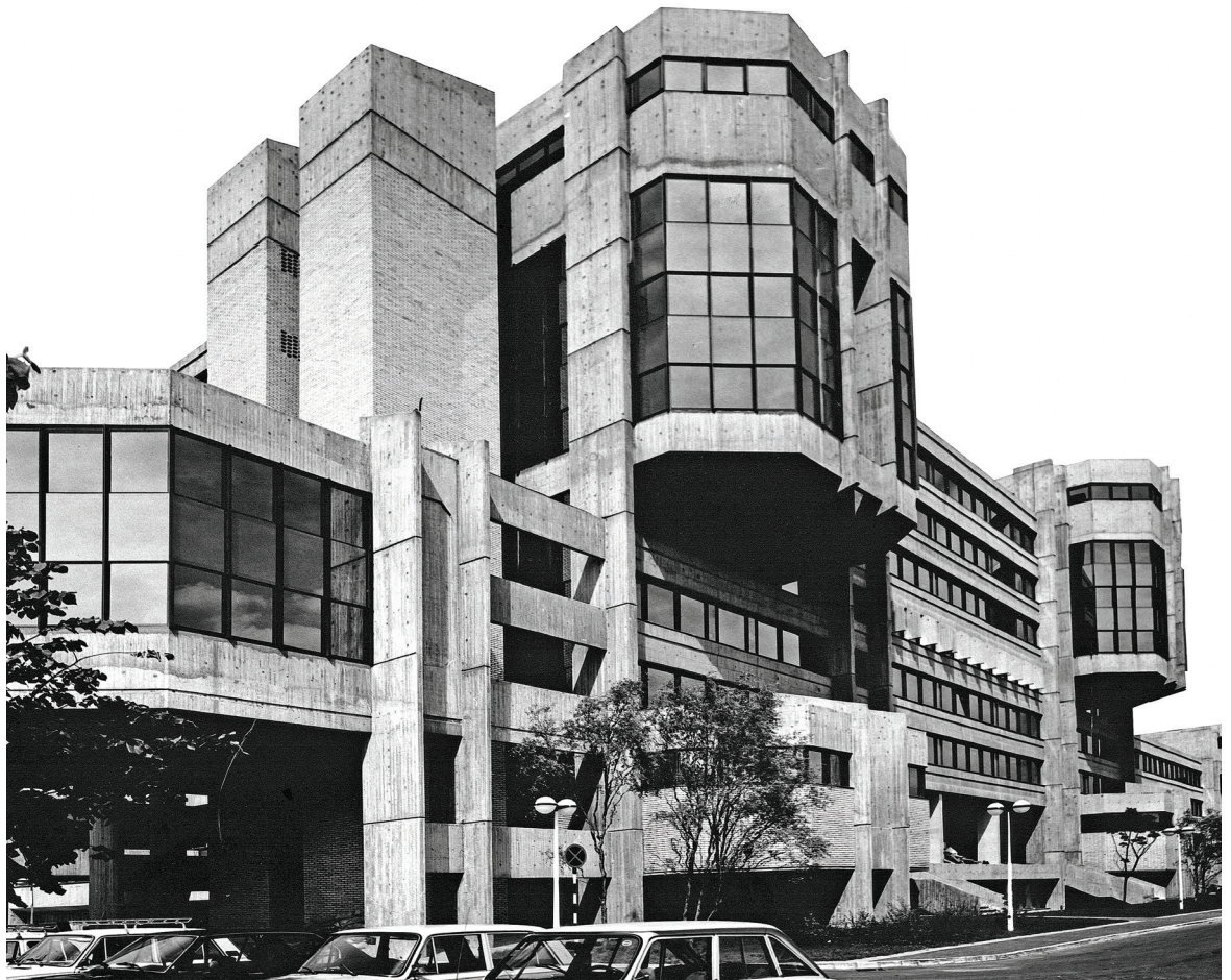
Зграда Савезног извршног већа СИБ III, Нови Београд, арх. Љупко Ђурчић, 1975.
