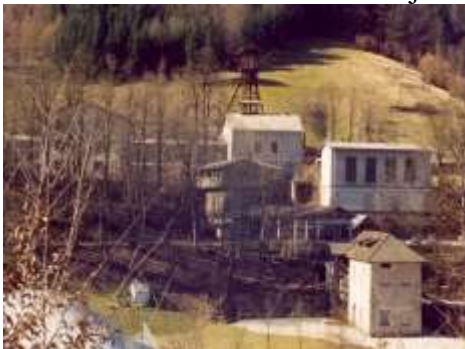
Slika 3. Zgrada vodenog kola za ispušavanje vode i zgrada ulaza u okno
