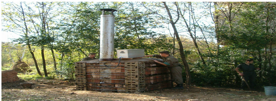
Slika 13 – Zidanje peći ciglom i busenom i završni radovi Figure 13 – Masonry with brick and finishing work
