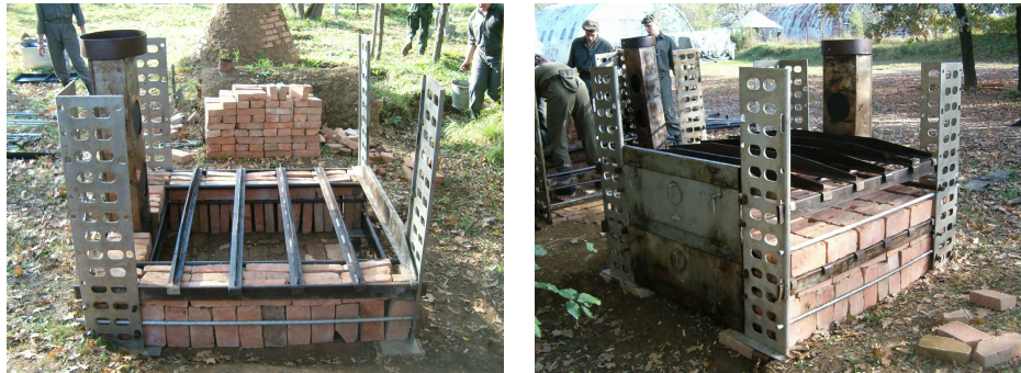
Slika 12 – Zidanje peći Figure 12 – Masonry work
