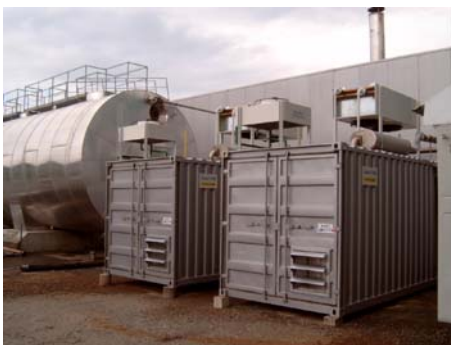
Figure 10 – Modlany, CZ, TEDOM Cento 150 SP BIO 150 kWe, 192 kWt Puc. 10 – Modlany, CZ, TEDOM Cento 150 SP BIO 150 kWe, 192 kWt Слика 10 – Modlany, CZ, TEDOM Cento 150 SP BIO 150 kWe, 192 kWt
