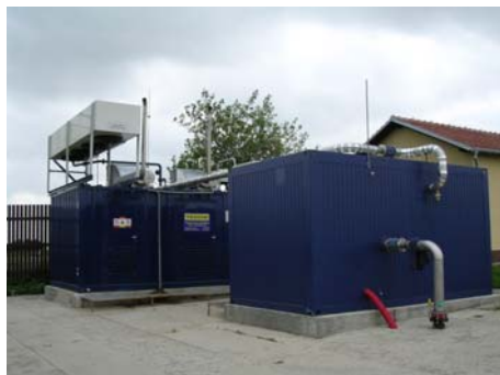
Figure 11 – Petruvky, CZ, TEDOM Cento T 300 SP 300 kWe, 370 kWt Puc. 11 – Petruvky, CZ, TEDOM Cento T 300 SP 300 kWe, 370 kWt Слика 11 – Petruvky, CZ, TEDOM Cento T 300 SP 300 kWe, 370 kWt
