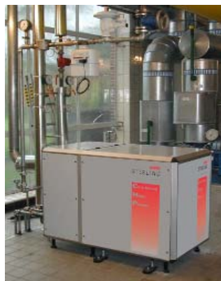
Figure 7 – Solo Рис. 7 – Solo (Stirling двигатель) Слика 7 – Solo (Stirling мотор)
