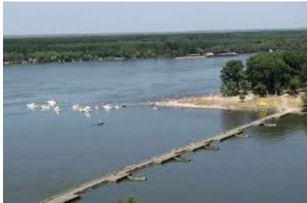
Figure 3 – Pontoon bridge class 20 Рис. 3 – Понтонный мост класс 20 Слика 3 – Понтонски мост класе 20
