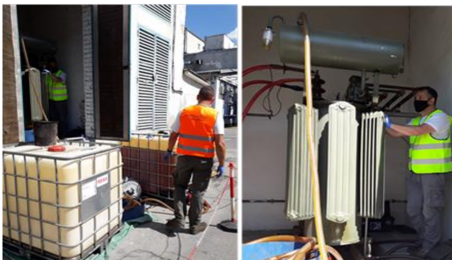
Slika 5. Ispiranje i nalivanje transformatora obrađenim uljem
