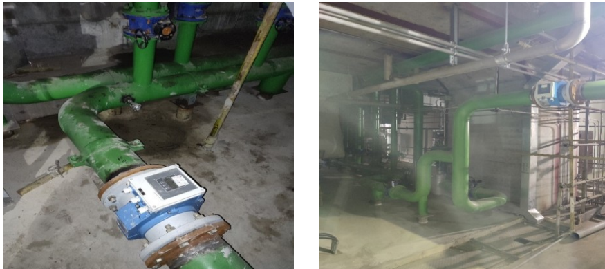
Slika 4.2 - Merenje protoka i temperature rashladne vode za hlađenje vodonika
