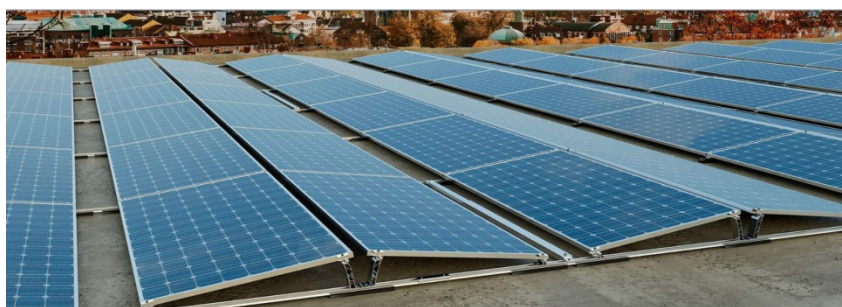
Slika 6. Način postavljanja fotonaponskih modula u A-dome konfiguraciju.
