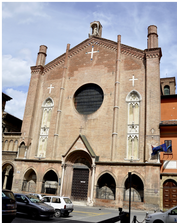
Слика 1: Сан Ђакомо Мађоре, Болоња, западна фасада
